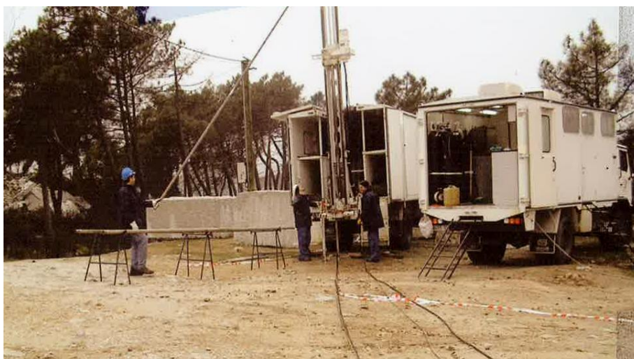
UMH realizando ensayos de baja permeabilidad
