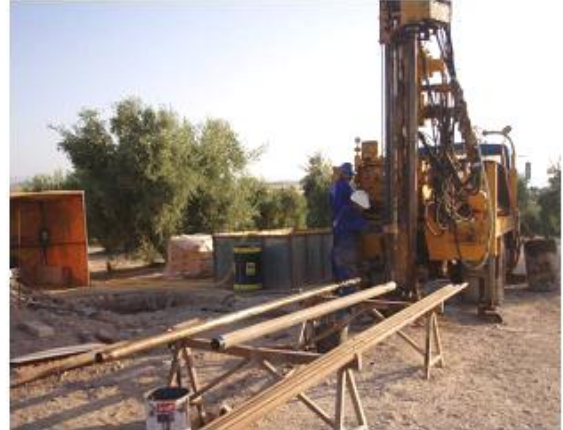
Sonda montada sobre camión
